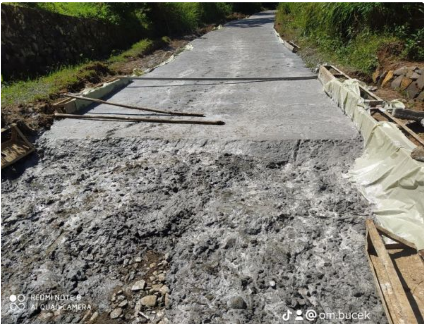
Pengerjaan Cor beton rehabilitasi jalan Cihara-Sukahujan
